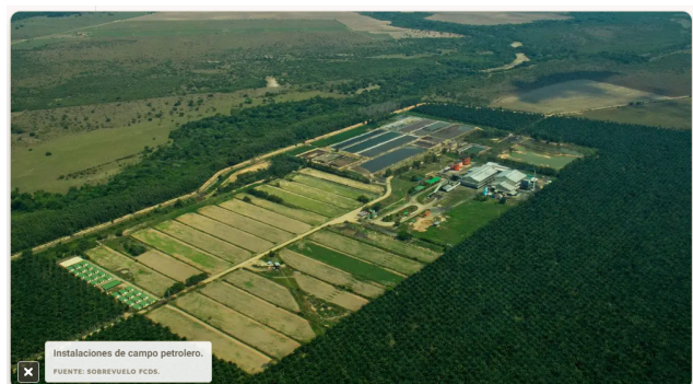
Ilustración 6. Instalaciones de campo petrolero en la Amazonía.
